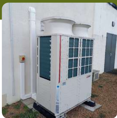
Système DRV du bâtiment Montcineyre
