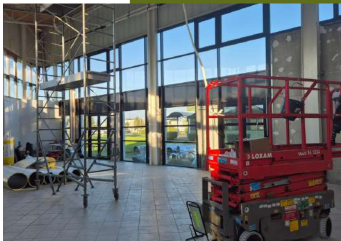
RÉNOVATION ÉNERGÉTIQUE DU BÂTIMENT D'ACCUEIL SEPTEMBRE-DÉCEMBRE 2025
